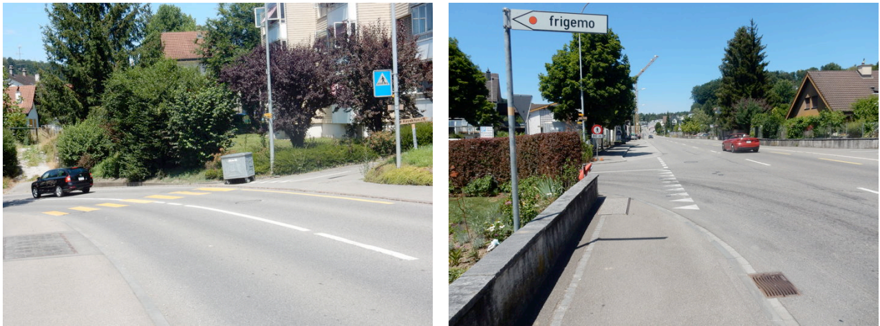
Abb. 7: Ungünstige/ungenügende Querungshilfen und Trottoirunterbrüche entlang von verkehrsorientierten Strassen sind Lücken im Netz guter Fussverkehrsverbindungen
