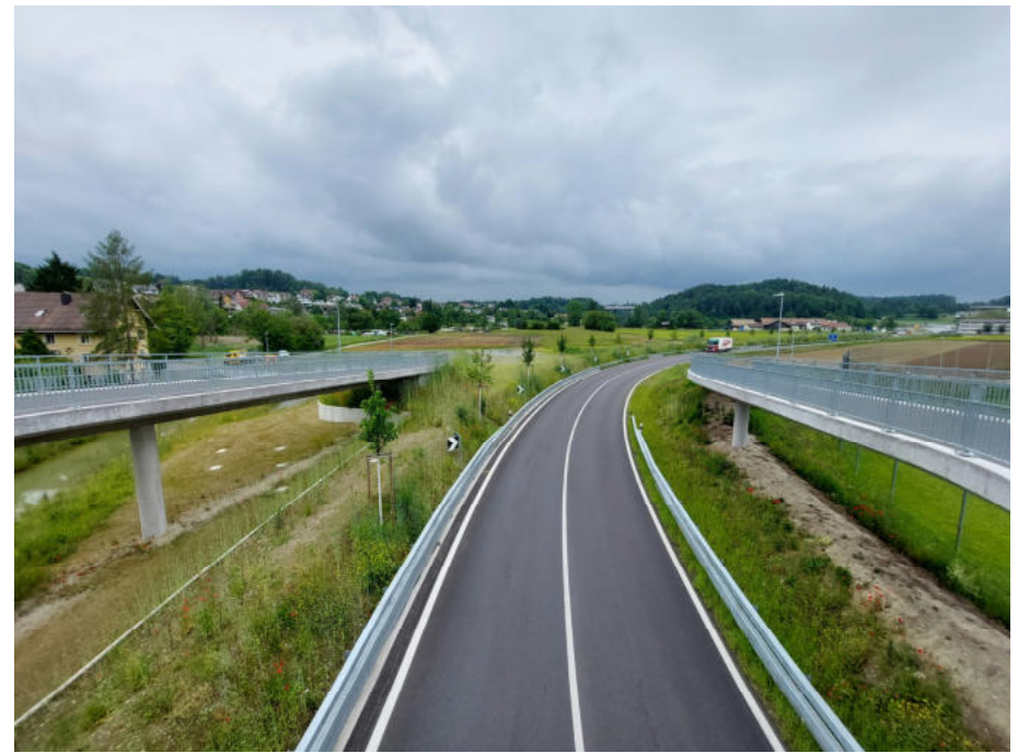
Foto der ausgeführten Umfahrung, SKK AG 2026
